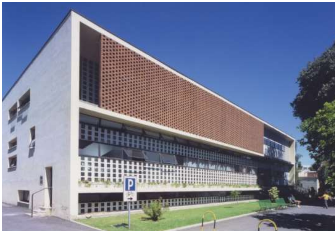
Figura 13. Il Dispensario antitubercolare, oggi poliambulatorio Gardella
