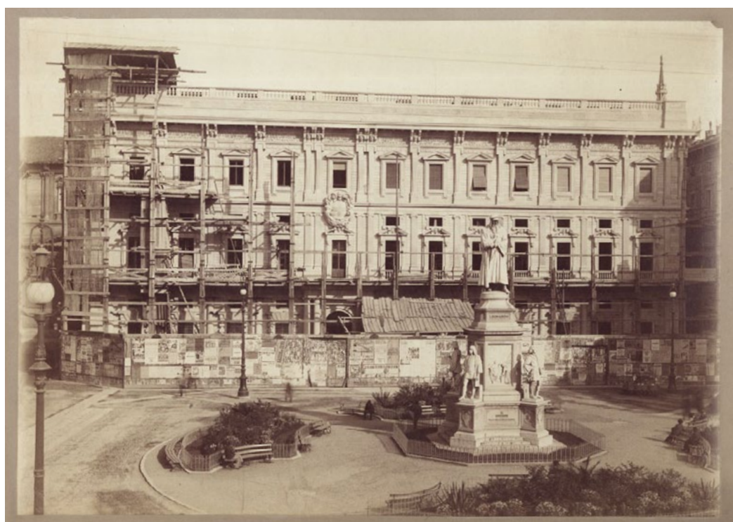
Figura 0.26 - Anonimo, Cantiere della facciata di Palazzo Marino su Piazza della Scala, costruita su progetto di Luca Beltrami a partire dal 1886, stampa all'albumina, 1892 ca., Milano, Civico Archivio Fotografico di Milano, Raccolta Beltrami, inv. RLB 2743, CC BY-SA.
