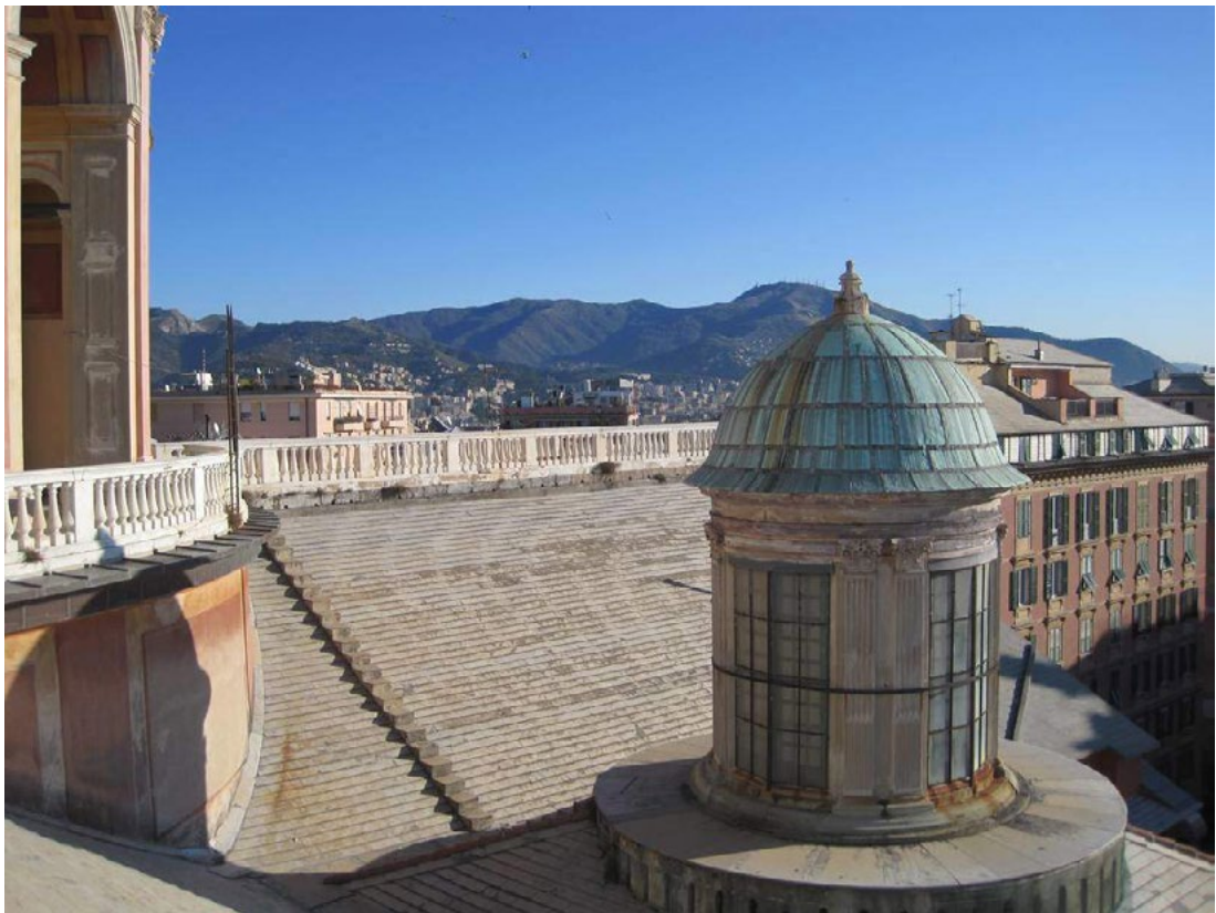
Figura 2.36 - Galeazzo Alessi, Chiesa di Santa Maria di Carignano, Genova, progettata nel 1549. La fotografia mostra i “corridori” (terrazze panoramiche) sul tetto della chiesa.
