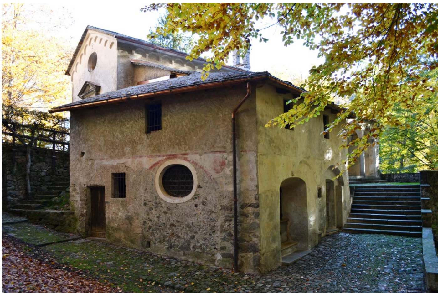
Figura 2.23 - Complesso di Nazareth (attuali cappelle 2-4), Sacro Monte di Varallo. Nel complesso ideato da Bernardino Caimi, l'edificio in primo piano costituiva il portico della Grotta dell' Annunciazione (Fig. 2.8). L'edificio fu sopraelevato negli ultimi decenni del Cinquecento e le arcate furono tamponate con la costruzione dell'attuale cappella 4 ( Il Sogno di San Giuseppe ). Nell'angolo dell'edificio si può notare la cosiddetta "muratura calcestre".
