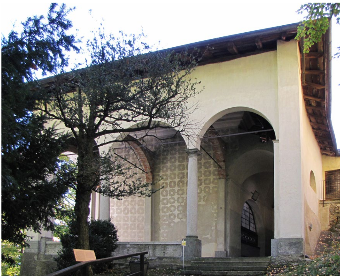
Figura 2.25 - Gaudenzio Ferrari (?), Cappella dell'Arrivo dei Magi, Sacro Monte di Varallo, 1521-25. La cappella ha subito molte modifiche nel corso dei secoli. Sulla destra si può vedere il portico seicentesco e in primo piano le arcate del portico ottocentesco. Durante l'ultimo restauro sono emerse le decorazioni a sgraffito della cappella gaudenziana.
