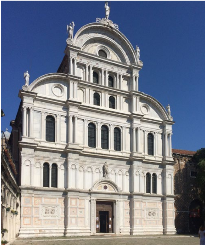
Figura 3.23 - Antonio Gambello e Marco Codussi, Facciata della Chiesa di San Zaccaria, Venezia, 1480-1500 ca.
