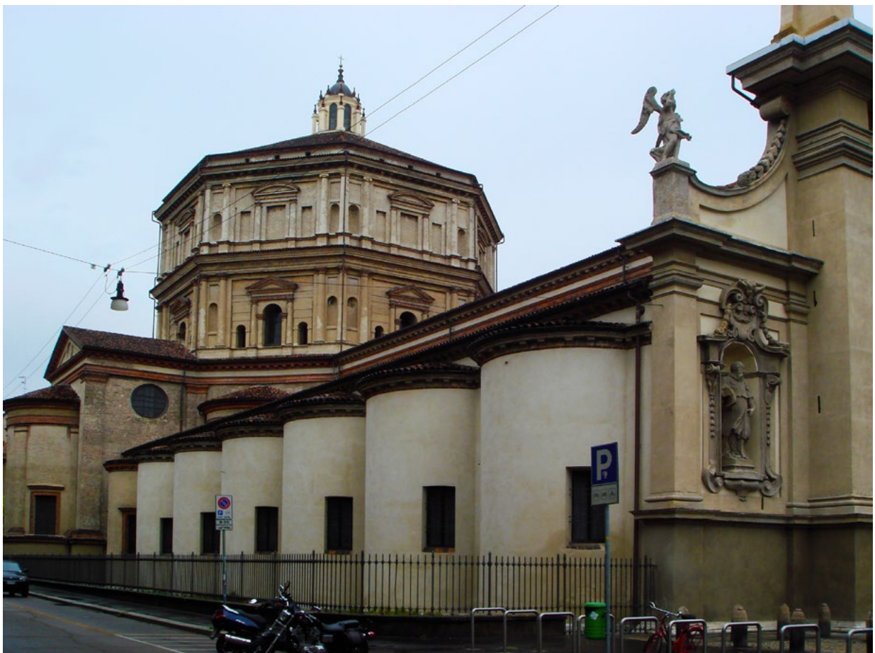
Figura 3.91 - Martino dell'Acqua (?), Tiburio della chiesa di Santa Maria della Passione a Milano, 1549-54.
