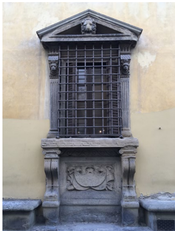
Figura 0.30 - Galeazzo Alessi (attribuito), Finestra inginocchiata, costruita intorno al 1555-65, Firenze, Palazzo Sforza-Almeni.
