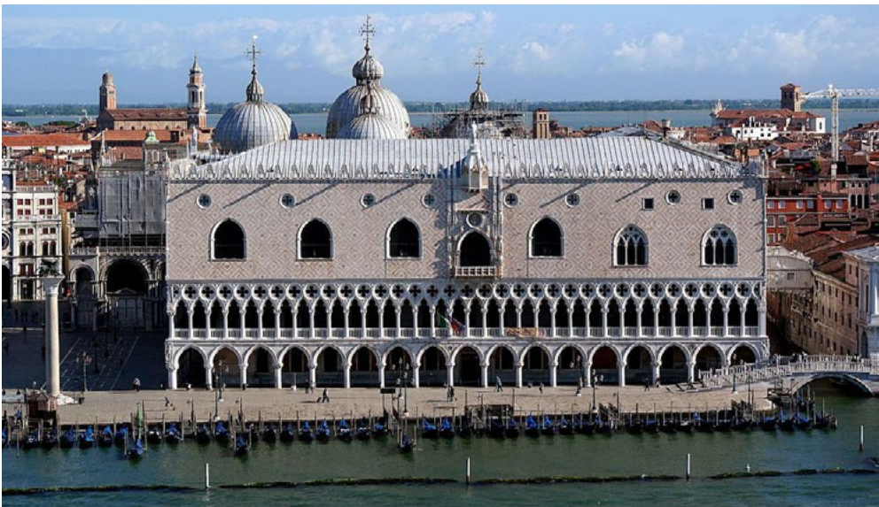
Figura 3.29 - Facciata di Palazzo Ducale, Venezia, costruita a partire dal 1424.
