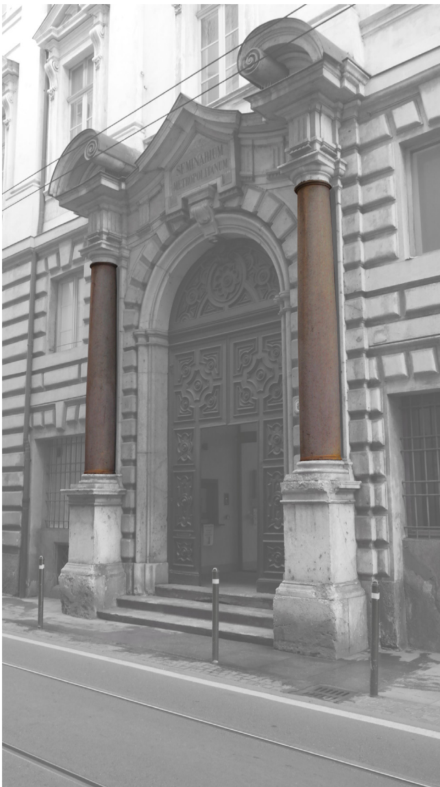
fig. 2 – Il portale del Seminario Metropolitano di Torino sull’attuale via XX Settembre, già Contrada del Seminario: L’effetto cromatico mira a evidenziare gli elementi in granito (foto ed elaborazione dell’autore).
