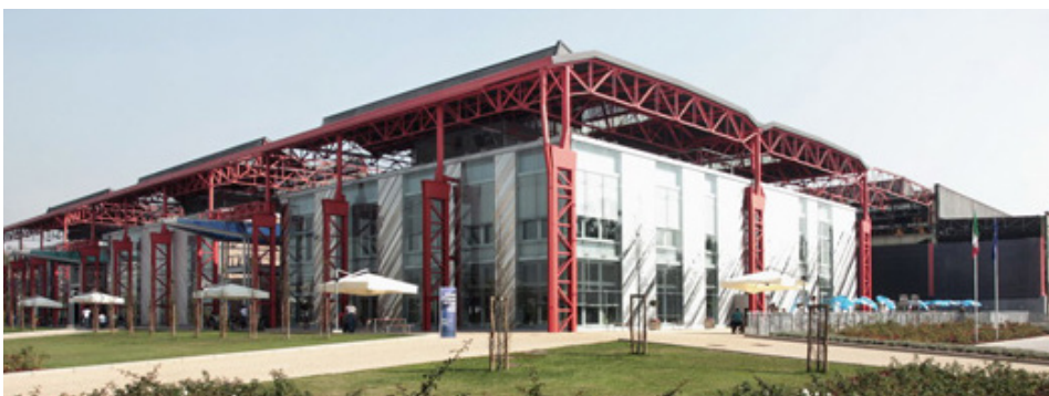
Figure 5.23 Politecnico di Torino Mirafiori campus - Cittadella Politecnica del Design e della Mobilità Sostenibili campus on ex-industrial FIAT (2012) - Courtesy Dipartimento di architetture and design Politecnico di Torino
