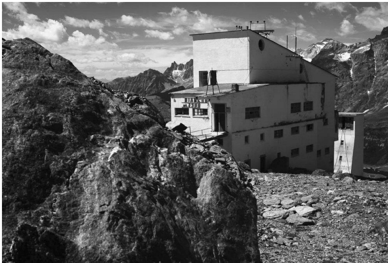
Arrivo della funivia del Furgenn, attualmente abbandonata. Realizzata dall'arch. Mollino e Ing. Zignoli nel 1952, Cervinia
