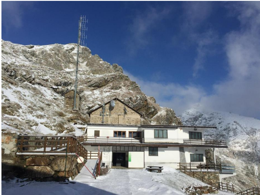
Figura 23 - Facciata principale stazione di monte Oropa_ Oropa Sport
