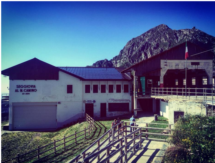
Figura 24 - Prospetto principale Ex seggiovia e partenza Cestovia
