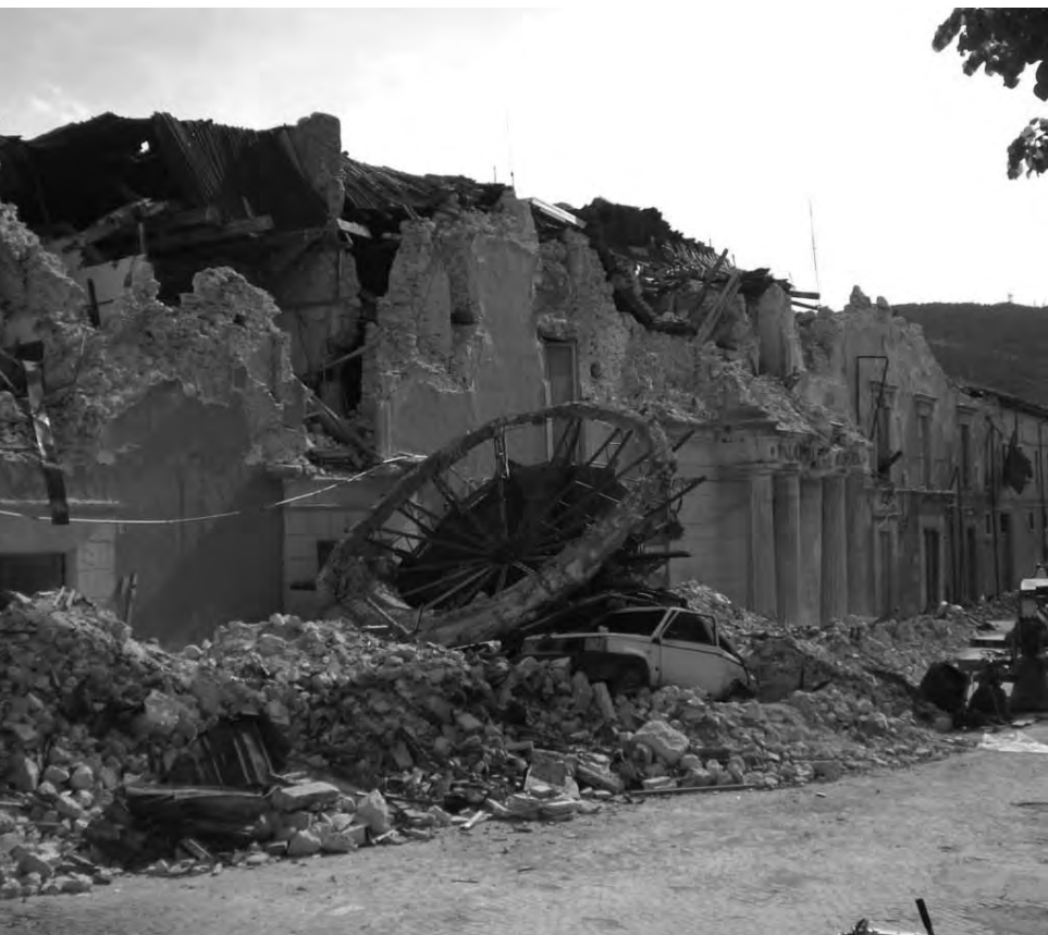
L’edificio distrutto della Prefettura de L’Aquila
