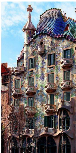
Fig. 23 Casa Batllò, Barcelona (1906)
