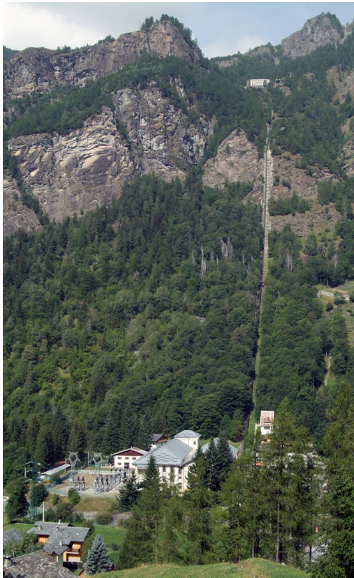
Figura 5. La cabina di pompaggio di Promeron in Valtournenche; in basso la Centrale di Maen (foto Studio Publica, 2017).
