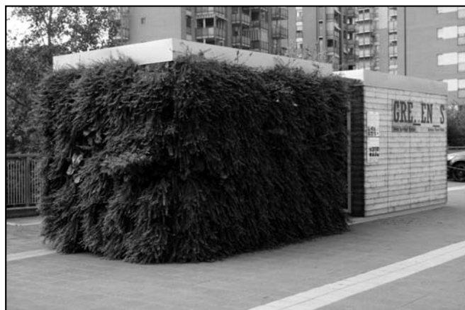
Figura 1 Edificio campione utilizzato per i monitoraggi situato a Environment Park, Torino (I)
