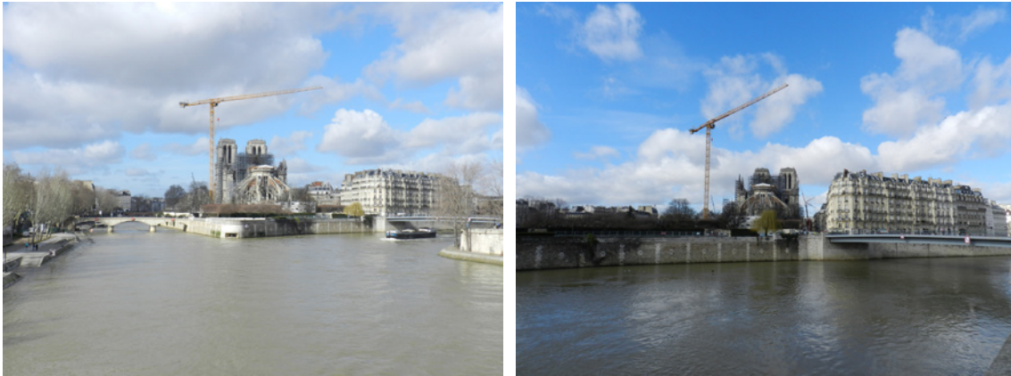
Figura 18a-b Lo skyline parigino modificato dopo l'incendio. Febbraio 2020. Fotografia dell'Autore
