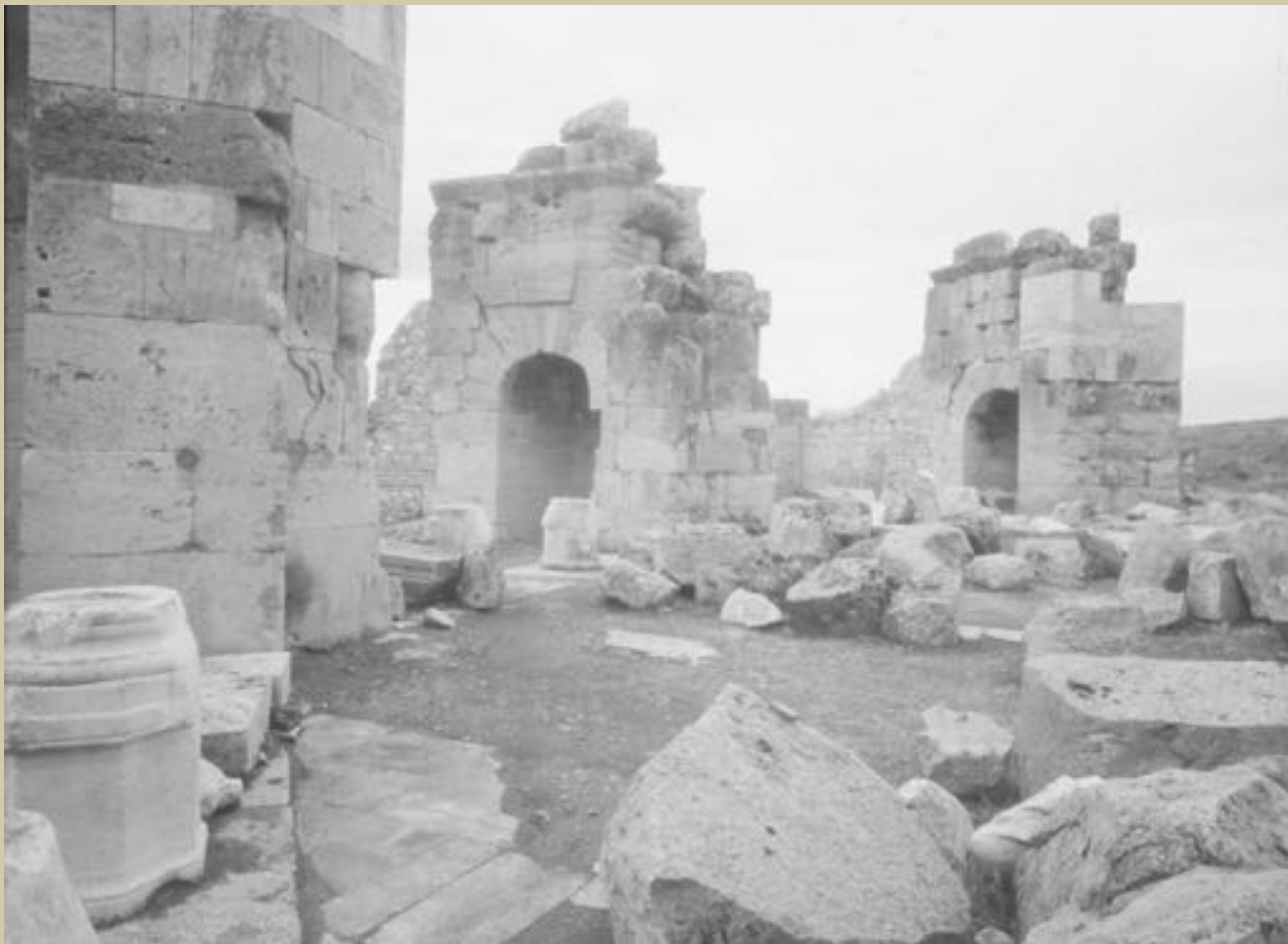
4. Martyrion di San Filippo, pilastri della cupola dopo il restauro, 1974, diapositiva (originale a colori).
