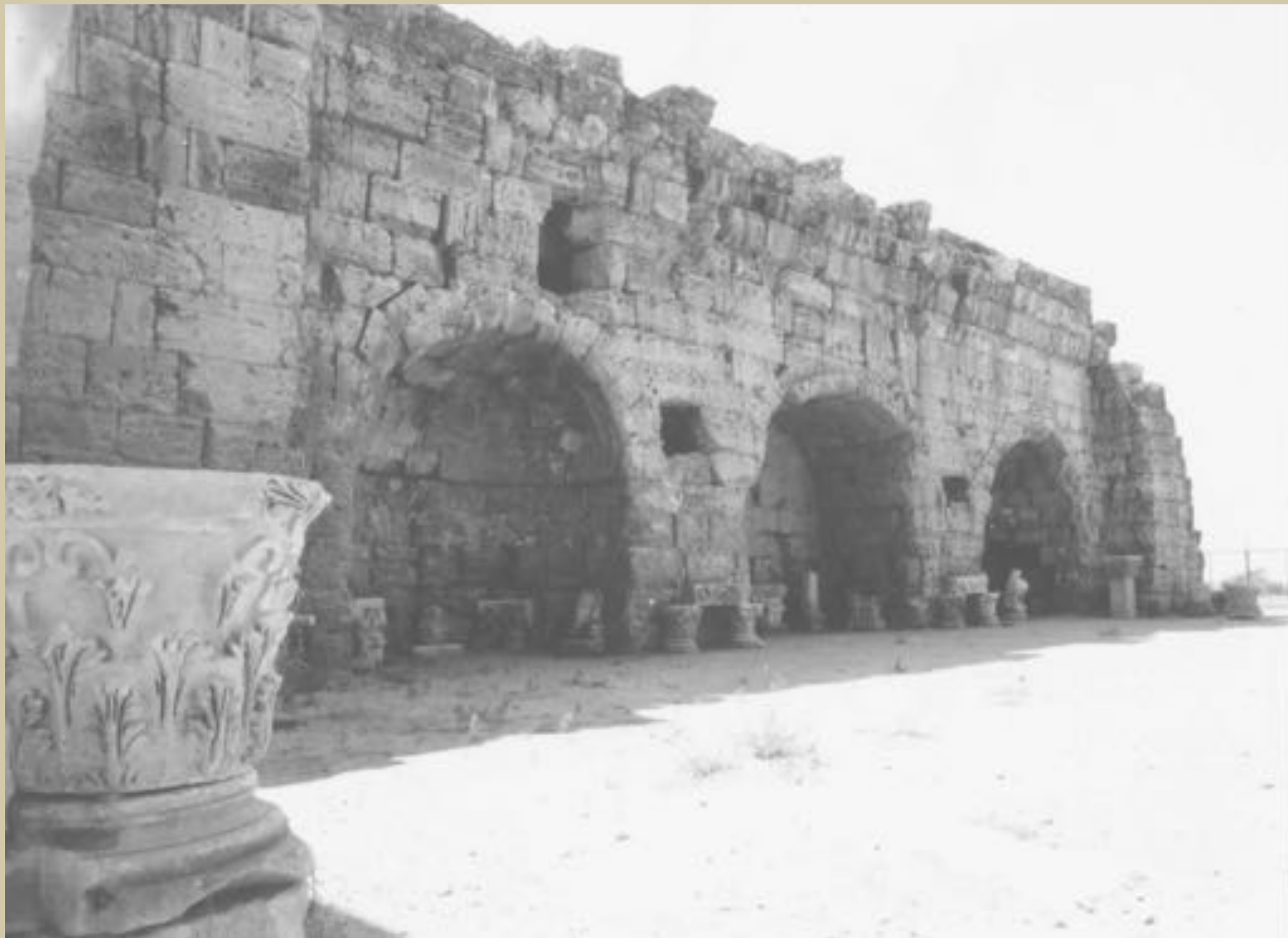
5. Terme, resti di uno dei grandi ambienti a nicchie originariamente coperto con volta a botte, 1978, negativo b/n su pellicola. AH, Terme urbane V, 1978, C78
