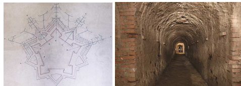
Fig. 6. Left: Agostino Chiodo, Piano Generale delle Contromine della Cittadella di Torino, in Raccolta dei disegni delle fortificazioni esistenti negli Stati di terraferma del Re di Sardegna ordinata da S.M. il Re Carlo Alberto... (Biblioteca Reale, Disegni, O.XIII). Right: General view of the lower capital gallery in the countermine system of the ravelin “del Soccorso” (P. Bevilacqua).
