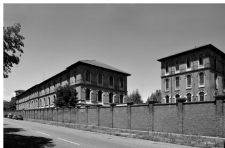
Fig. 36. I fabbricati del complesso della caserma Monte Grappa.
