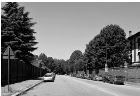
Fig. 32. I muri perimetrali in via De Cristoforis tra la Morelli di Popolo e la Dabormida.
