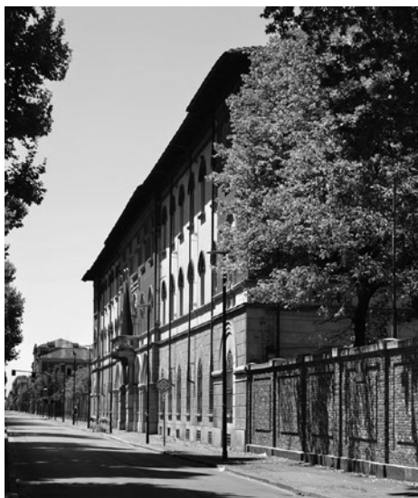
Fig. 33. Il fronte principale della caserma Dabormida su corso Unione Sovietica.
