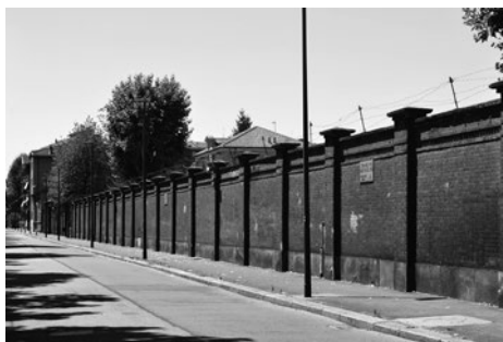
Fig. 31. Il lungo muro perimetrale della Morelli di Popolo su corso Unione Sovietica.
