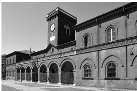
Fig. 21. L'ex palazzina direzionale.
