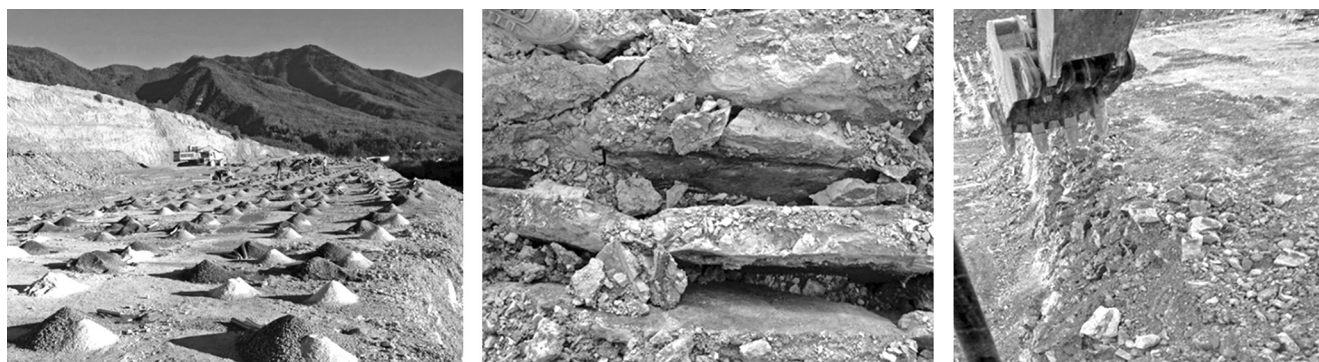
Fig. 2. A sinistra, preparazione di una volata di preminaggio; al centro: vista in pianta degli strati di marna sub-verticali sconnessi grazie all'azione dell'esplosivo; a destra: rimozione del materiale mediante escavatore.
