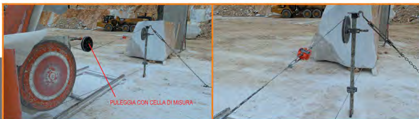
Fig.16 Installazione del dinamometro per la taratura / Installation of the dynamometer for calibration
