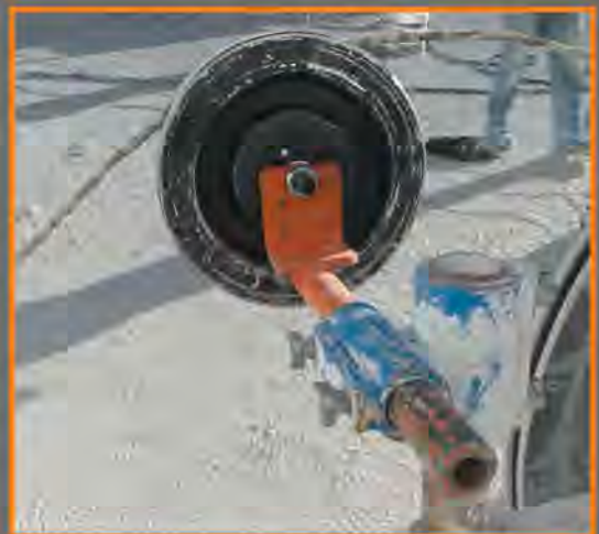
Fig.19 Cella di carico installata con indicatore verso il basso e fune su lato superiore / Load cell installed with the indicator down and the rope on the upper side
