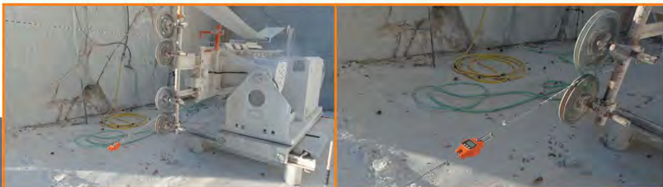
Fig.10 Installazione del dinamometro per la taratura / Installation of the dynamometer for calibration
