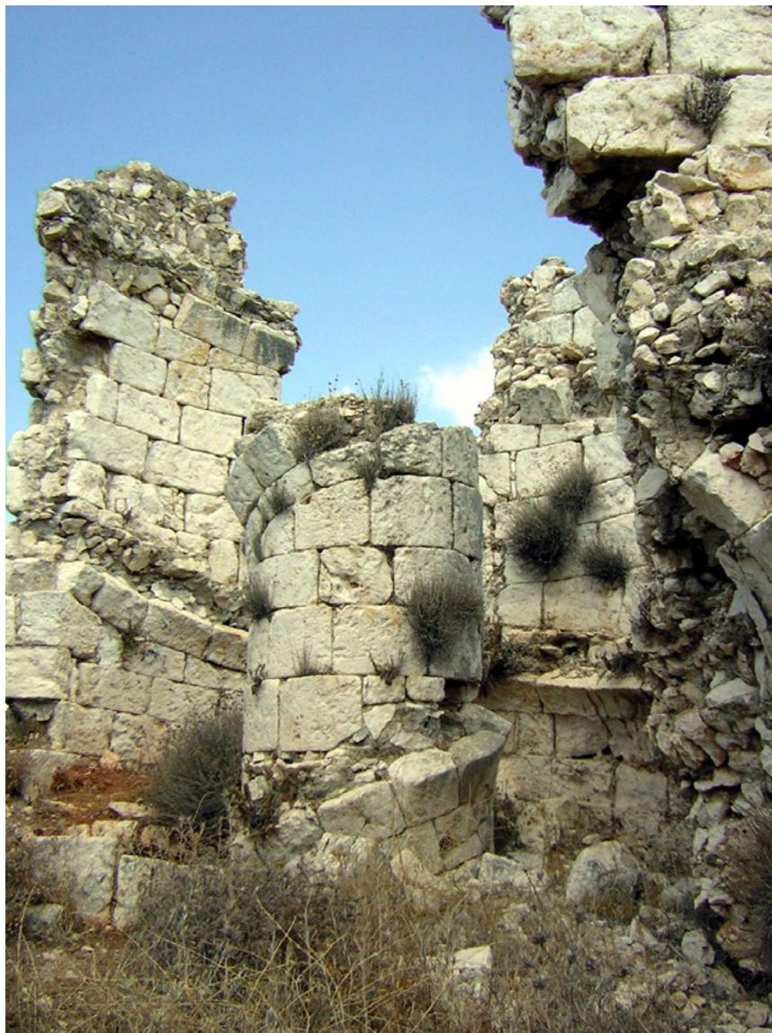
Figura 6. Akkale. Particolare delle strutture superstiti della scala a chiocciola che collegava i differenti livelli del grande palazzo bizantino (foto E. Romeo, 2006).
