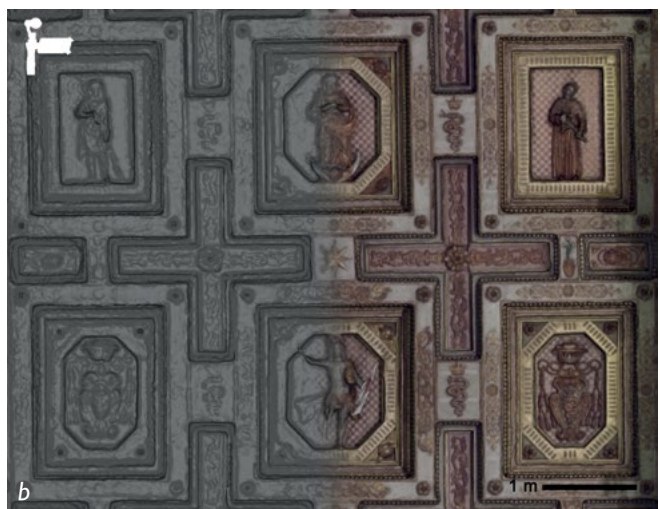
Figura 4. Dettaglio del modello 3D (texturizzato e non texturizzato) di un lacunare: (a) modello generato da camera DSLR; (b) modello generato da steadycam .
