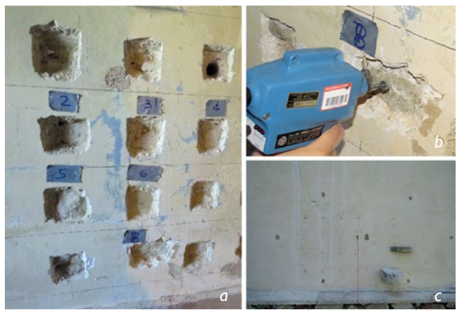
Figura 18. a) griglia interna dei punti di prova; b) martellino elettrico strumentato per la determinazione dell'onda sonora; c) griglia esterna dei punti con l'applicazione dell'accelerometro.
