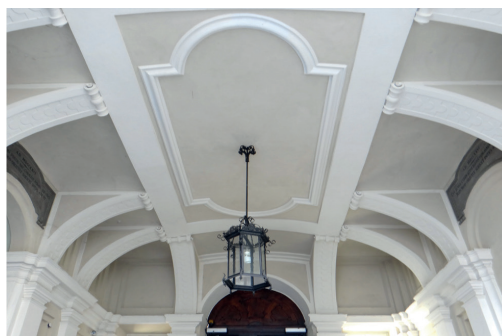
Fig. 9. Volta a fascioni con voltine indipendenti nell'atrio di Palazzo Martini di Cigala (foto di Marco Vitali).
