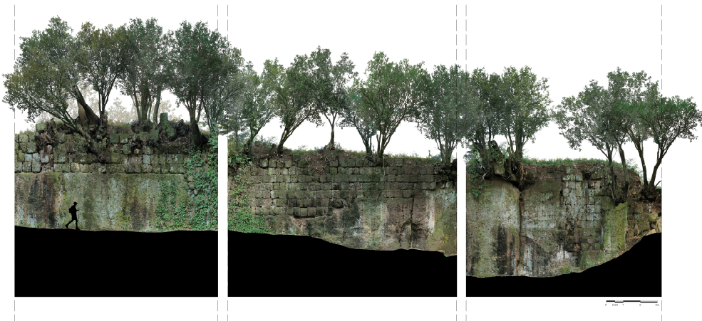
Fig. 5. Fotopiano delle mura difensive nel tratto semicostruito (rilievo ed elaborazione di T. Vagnarelli).
