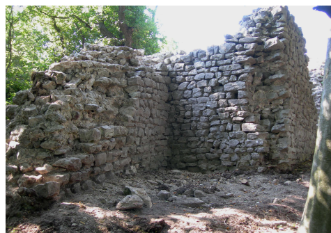
Fig. 3. Bagnasco (CN): la torre del sistema difensivo di Santa Giulitta durante i lavori di pulitura archeologica.
