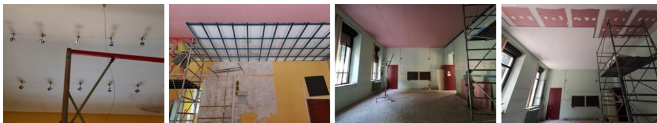
Figura 2 – Installazione tramite pendinatura e sottostruttura metallica del controsoffitto antifondellamento Gyproc Fireline e, nell'ultima immagine a destra, dei pannelli fonoassorbenti Ecophon Master™ F in aderenza.
