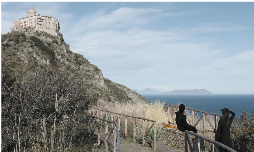
Fig. 5 – Sentiero “Coda di Volpe”: un tratto di percorso e belvedere, entrambi realizzati con tecniche di ingegneria naturalistica. Elaborazione grafica degli autori.
