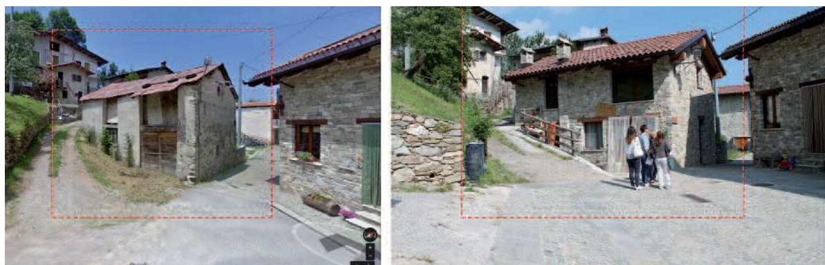
Figura 7 Confronto dell'aspetto dell'edificio pre e post intervento di un edificio recuperato con i contributi della misura 322 nella borgata Baracco - Roccaforte di Mondovì (CN) ( https://www.google.it/maps/@44.2755529,7.749961,3a,90y,334.18h,94.37t/data=!3m6!1e1!3m4!1s5jchC4x2NLXgOYI-AxsvHQ!2e0!7i113312!8i6656 )
