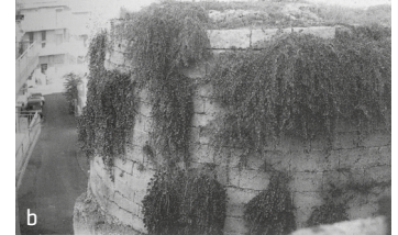
Fig. 2 Carlentini (SR), a. particolare del torrione nord- ovest prima dell’intervento di restauro b. particolare del torrione nord-est prima dell’intervento di restauro
