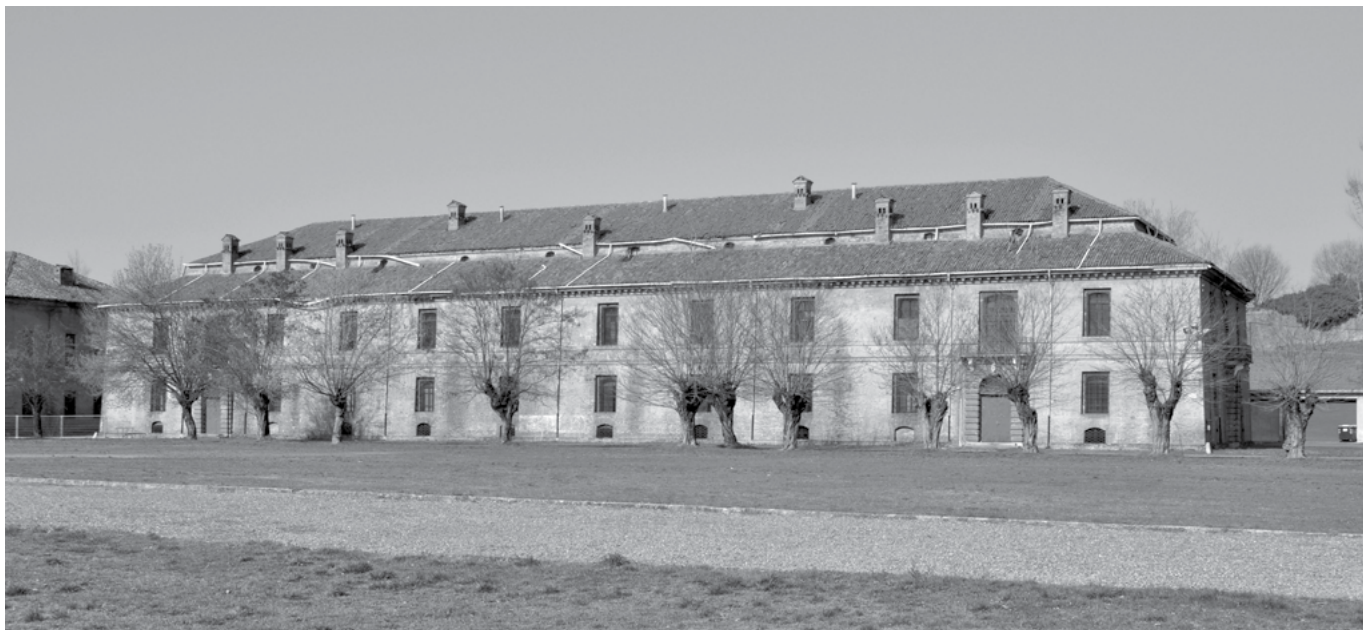
Figura 15. Il quartiere di San Carlo nella Cittadella di Alessandria (1760-1768), veduta dalla piazza d'Armi (foto E. Piccoli, 2017).
