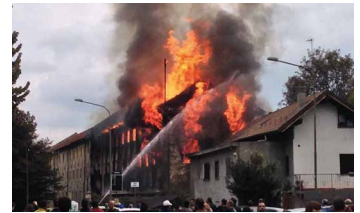
Fig. 4 Pinerolo (TO). Lavori di abbattimento del complesso della Fabbrica Elettrodi della Società Talco Grafite Val Chisone (foto: M. Calliero)
