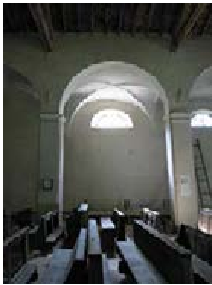
figg. 4, 5, 6 – Dettagli dell'interno della chiesa: le volte a crociera delle navate laterali, gli archi a tutto sesto di divisione tra le navate e l'orditura lignea della copertura della navata centrale.
