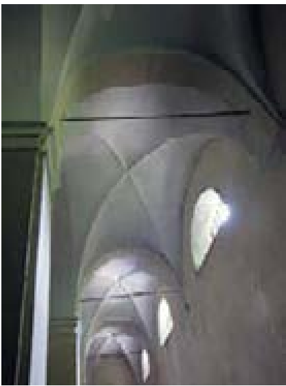
figg. 4, 5, 6 – Dettagli dell'interno della chiesa: le volte a crociera delle navate laterali, gli archi a tutto sesto di divisione tra le navate e l'orditura lignea della copertura della navata centrale.
