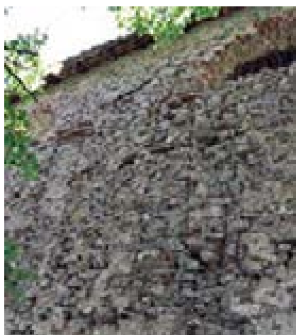
figg. 25, 26, 27 – Parete ovest della chiesa. Sono leggibili le tracce di strette e alte aperture poi tamponate, sottolineate in alcune parti da stipiti in laterizio.
