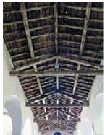
figg. 4, 5, 6 – Dettagli dell'interno della chiesa: le volte a crociera delle navate laterali, gli archi a tutto sesto di divisione tra le navate e l'orditura lignea della copertura della navata centrale.
