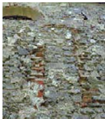
figg. 25, 26, 27 – Parete ovest della chiesa. Sono leggibili le tracce di strette e alte aperture poi tamponate, sottolineate in alcune parti da stipiti in laterizio.
