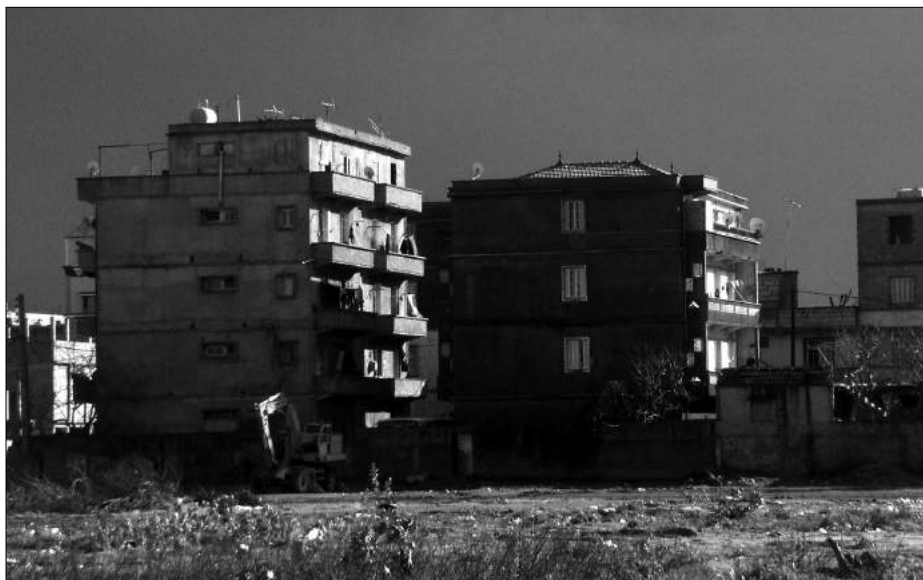
Fig. 9 – Pala meccanica messa a disposizione dei residenti di Cherarba dal Comune
