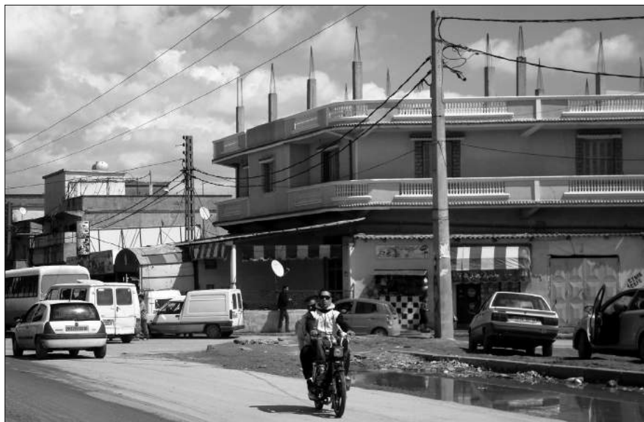
Fig. 3 – Strumenti di lavoro abbandonati, muri non intonacati, costruzioni non finite danno alle abitazioni di Cherarba l'aspetto di un cantiere permanente
