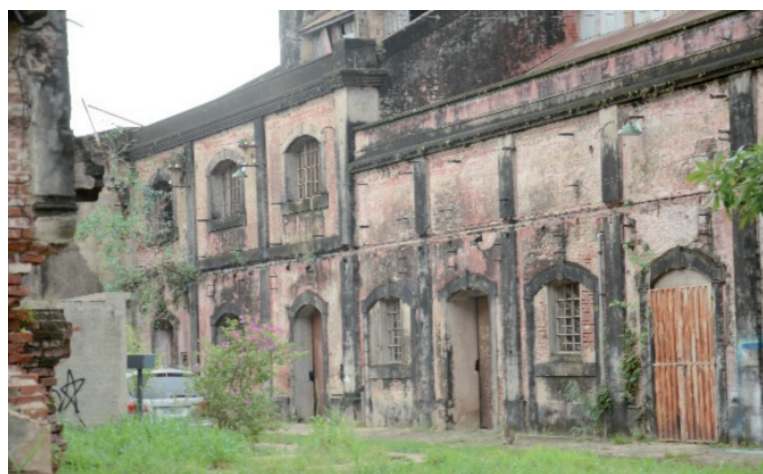
FIG. 2 Edifici produttivi de La Fabril (Resistencia), stato attuale Production warehouses at La Fabril (Resistencia), present state
