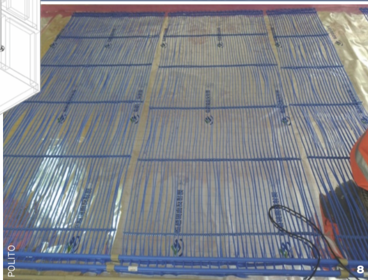
8. GLI IMPIANTI radianti capillari sono composti da pannelli formati da sottili tubi di polipropilene molto vicini fra loro, particolarmente performanti e facili da posare.
