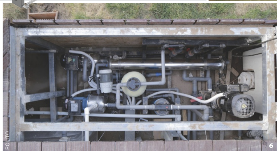
6. L'IMPIANTO DI DEPURAZIONE delle acque piovane e grigie dispone di filtri con materiali vegetali, a carboni attivi e di un sistema a osmosi inversa.
