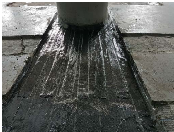
19a,b,c. La posa del rinforzo alla base del pilastro tondo.
