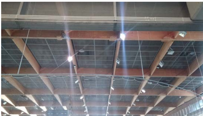
1b. La copertura in legno lamellare.
