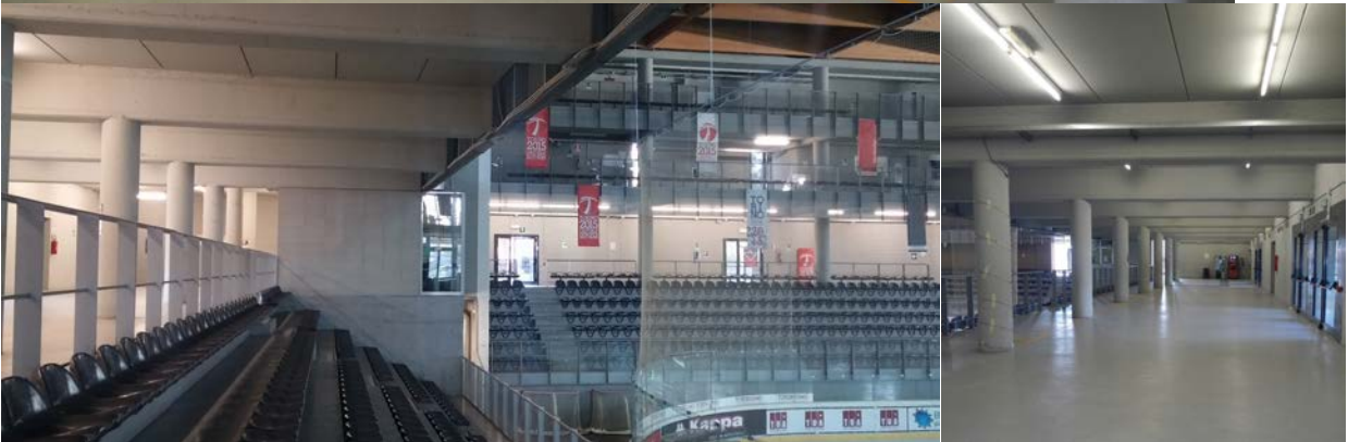
4a,b,c. Vista degli spazi a piano terreno.
