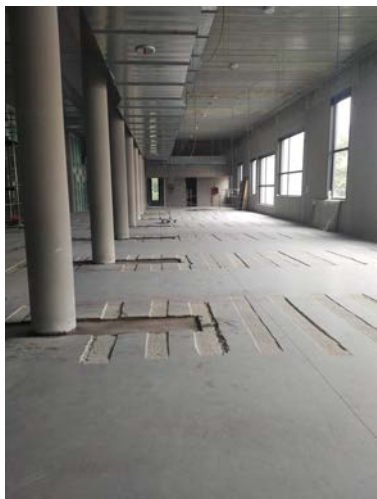
19a,b,c. La posa del rinforzo alla base del pilastro tondo.
