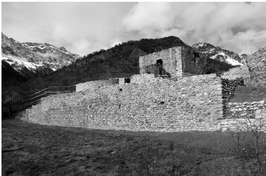
Bardonecchia, muro di cortina del castrum verso il borgo.
