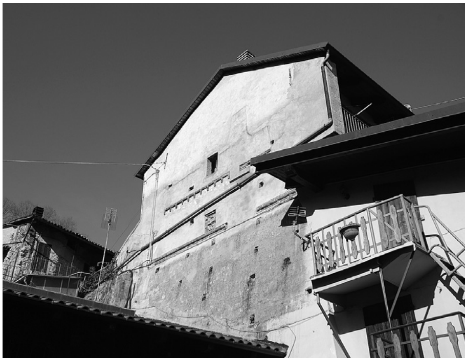
Sant' Ambrogio, castello abbaziale: murature medievali inglobate negli edifici adiacenti e pertinenti al suo recinto esterno.
