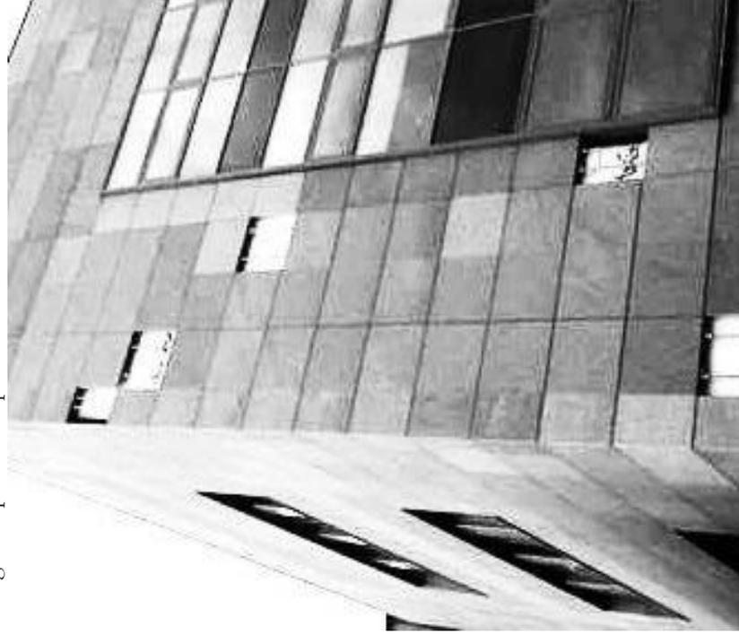
Fig. 2. Esempio di Gruppo formato da 50 lastre (10 righe per 5 colonne). Nell'immagine alcune lastre rimosse a seguito di controllo; è visibile la sottostruttura portante.
