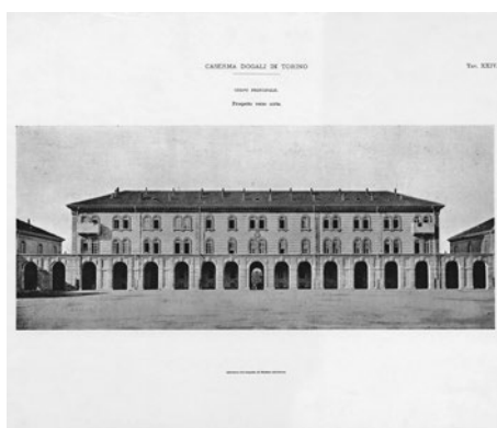
Fig. 12. Caserma Dogali in Torino. Corpo principale. Prospetto verso corte (ASCT, Collezione Simeom , D 753, tav. XXIV).
