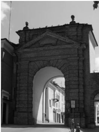
Fig. 7. La porta di San Martino vista da ovest.
