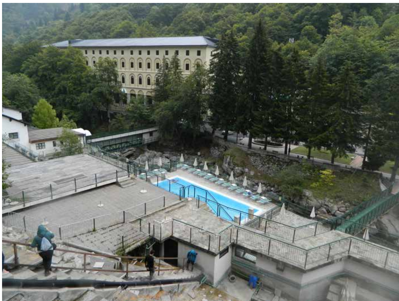
Vista del complesso termale e dell'hotel dalle gradonate di coltura delle alghe, utilizzate per i trattamenti (fotografia degli autori).
