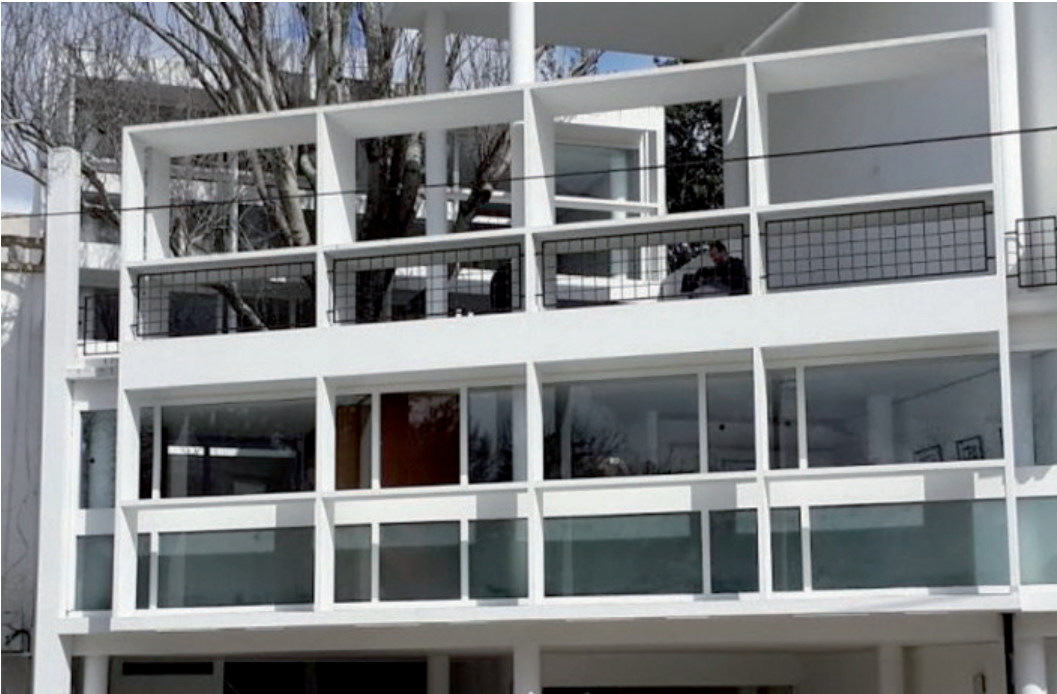
FIG. 1 Le Corbusier, Maison Curutchet, La Plata 1949-55: fronte brise-soleil Le Corbusier, Maison Curutchet, La Plata 1949-55: brise-soleil façade
