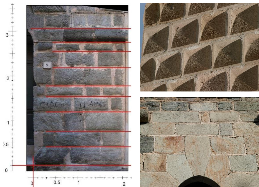
Figura 59 - Esempi di paramenti lapidei in opera quadrata. (a sinistra) Noli (SV). Bugnato a cuscino in prasinite (sec. XIII). (a destra alto) Perti, Finale Ligure (SV). Bugnato a diamanti in pietra di Finale (sec. XV). (a destra basso) Garessio, colle di Casotto (CN). Bugnato liscio in porfiroide (sec. XIII).
