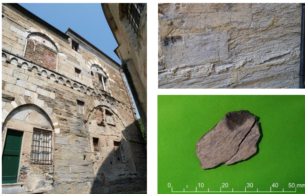
Figura 55 - Cogorno, fraz. San Salvatore dei Fieschi (GE). Palazzo Fieschi. (a destra alto) Dettaglio sul probabile punto di distacco. (a destra basso) Il campione CO-1.
