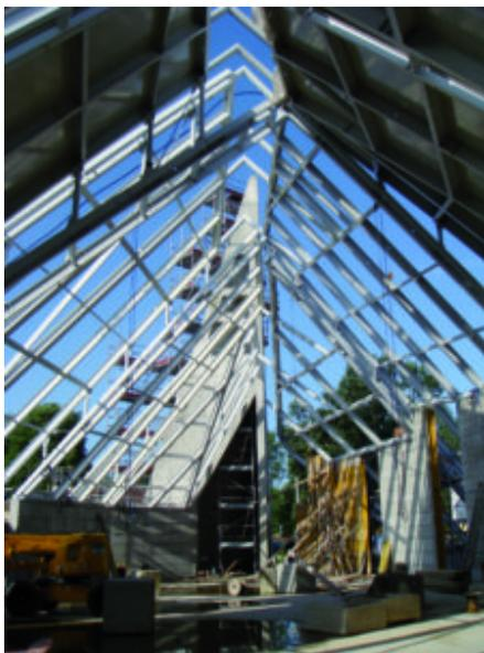
La cura delle strutture: il montaggio delle carpenterie della chiesa della Trasfigurazione ad Alba (Archicura, 2009)
