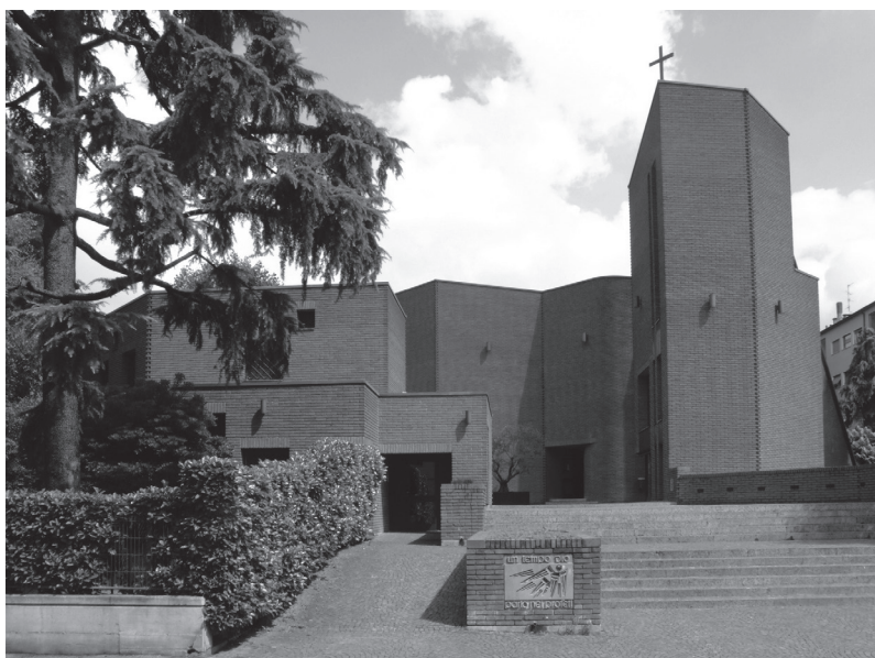
Figura 26. Monza, San Giuseppe (Justus Dahinden, 1972-1976), l'ingresso al complesso parrocchiale, che assume forma di "villaggio" raccolto attorno alla chiesa (foto Longhi).
