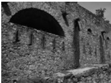
Fig. 6. Dettaglio delle murature esterne.
