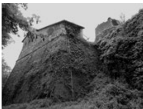
Fig. 16. Fortezza di Verrua, condizioni attuali della cortina muraria.
