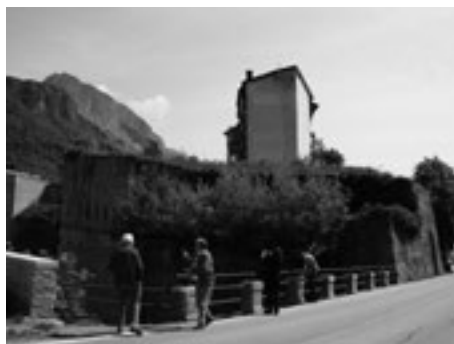
Fig. 5. Il costruito degli anni sessanta del XX secolo a ridosso del forte.
