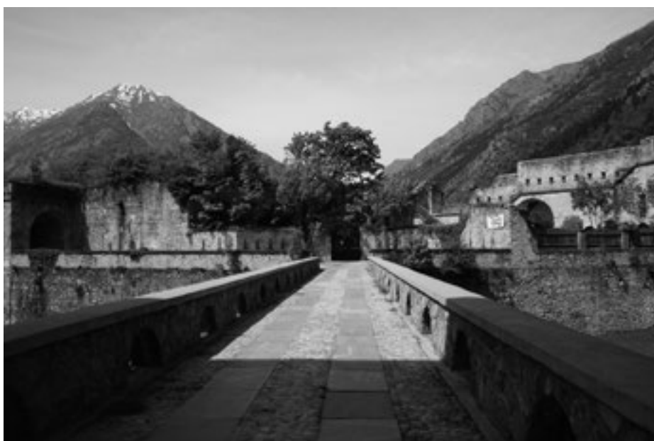
Fig. 3. Ponte d'ingresso alla porta di Francia, unico collegamento stradale fra Italia e Francia fino al 1927
