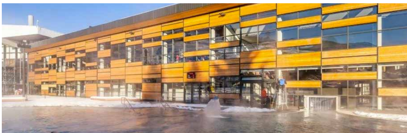
Il fronte prospiciente la vasca balneoludica per le attività en plein air, realizzata a fianco del bacino natatorio per il nuoto (Archivio Municipalità di Megève).
