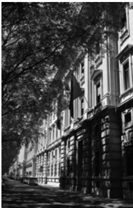
Fig. 11. La continuità dei fronti dei tre edifici militari di corso Vinzaglio visibile dal controviale.
