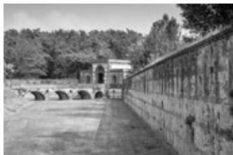
Fig. 14. Bastionata e ponte della Cittadella.
