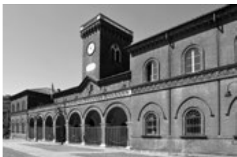
Fig. 21. L'ex palazzina direzionale.
