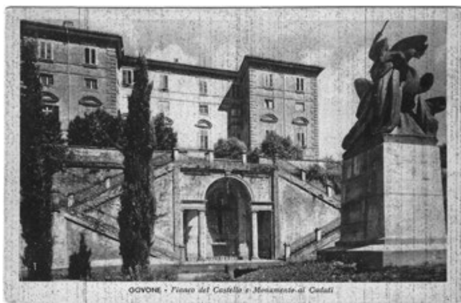
Fig. 2. Govone. Fianco del Castello e Monumento ai Caduti, cartolina, 1942 (collezione privata). In quest'immagine si può notare il nuovo Monumento ai Caduti di Emilio Musso e la trasformazione dello scalone con l'inserimento di un altare in luogo della fontana.
