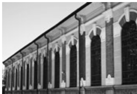
Fig. 30. Uno degli edifici delle cavallerizze.
