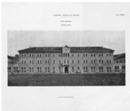
Fig. 11. Caserma Dogali in Torino. Corpo principale. Prospetto esterno (ASCT, Collezione Simeom , D 753, tav. XXIII).
