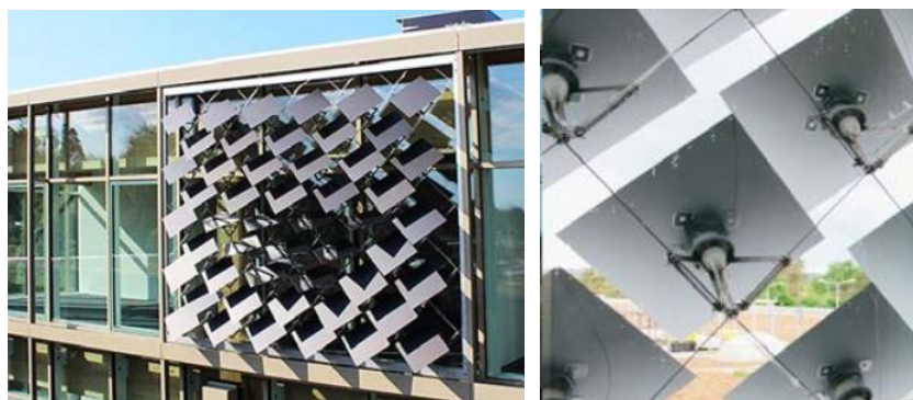
► Fig. 2: Pneumatic actuators (Kormaníková et al., 2017)
