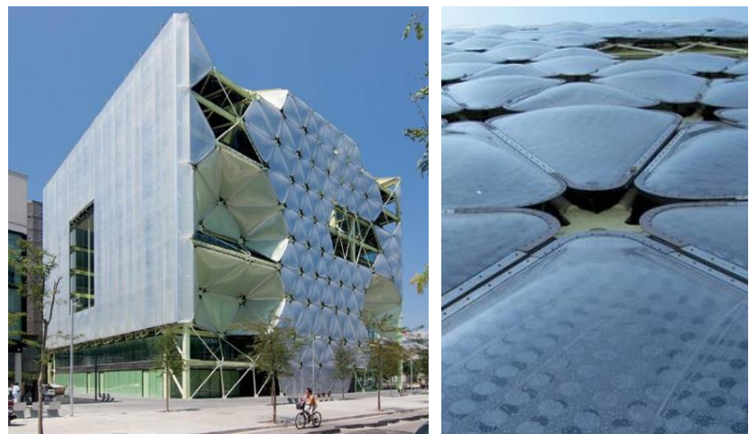
► Fig. 3: Pneumatic cells (Marysse, 2016)
