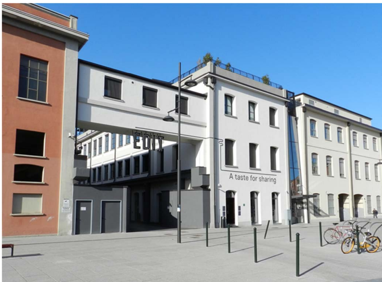
4: Ex-Incet, Torino. La facciata della porzione del fabbricato industriale che attualmente ospita il polo enogastronomico EDIT. (Foto di Manuela Mattone, 2018).
