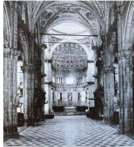
Fig. 13. Duomo di Como, navata centrale (da Gini 1972).
