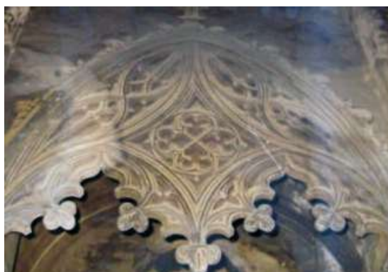
Fig. 22. Chiesa di San Bartolomeo, altare di Santa Caterina, particolare dell'arco. E' qui evidente il motivo ad intreccio paragonabile agli esempi voltati citati. (da A. Marotta, (a cura di), San Bartolomeo in Valenza: rilievi e indagini per il restauro , catalogo della mostra, Centro comunale di cultura, Gruppo femminile del club Turati, Valenza 1991, p. 22).
