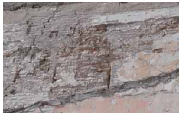
Fig. 14- Finestra ad arco bardellonato ricavata in rottura nell'ogiva della porta urbana e nel relativo tamponamento
