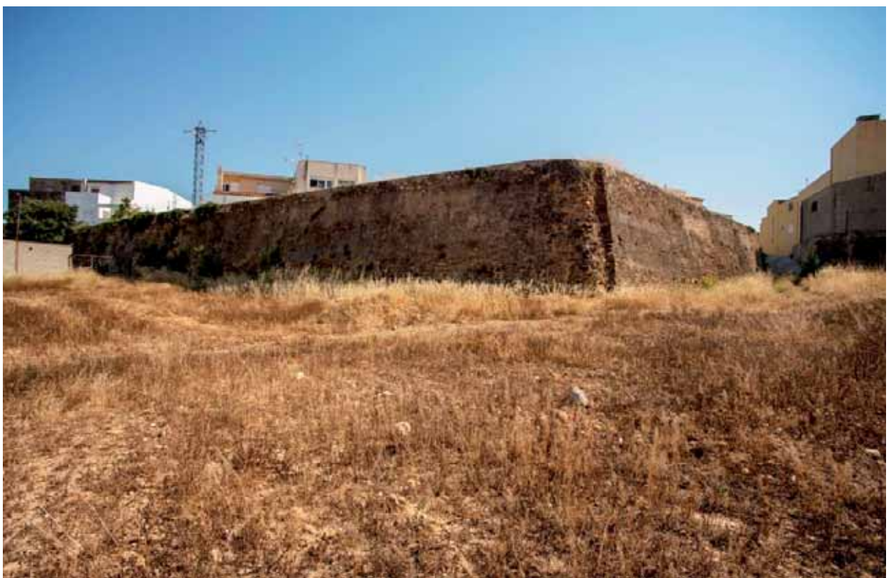
Fig. 12- Baluarte noreste de la fortificación de Traiguera. Foto del autor (2017)
