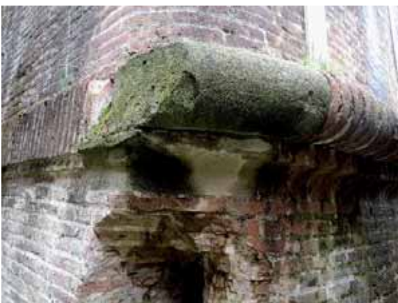
Fig. 6- Elemento architettonico in Pietra Serena
