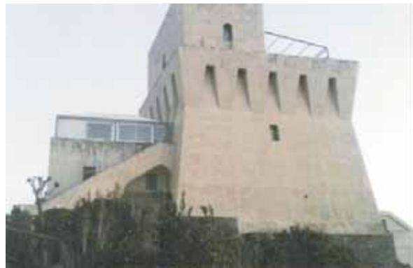
Fig. 4- Torre del Greco, Torre Bassana
