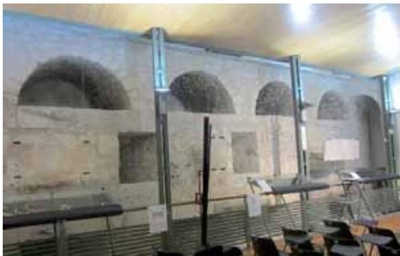
Fig. 14- Aperture per artiglieria presenti all'interno dei locali del baluardo Dusay (settore 2 fig.2). Si distinguono con chiarezza le due fasi costruttive legate alla trasformazione cinquecentesca attuata dai Paleari con l'elevazione dell'intero corpo di fabbrica
