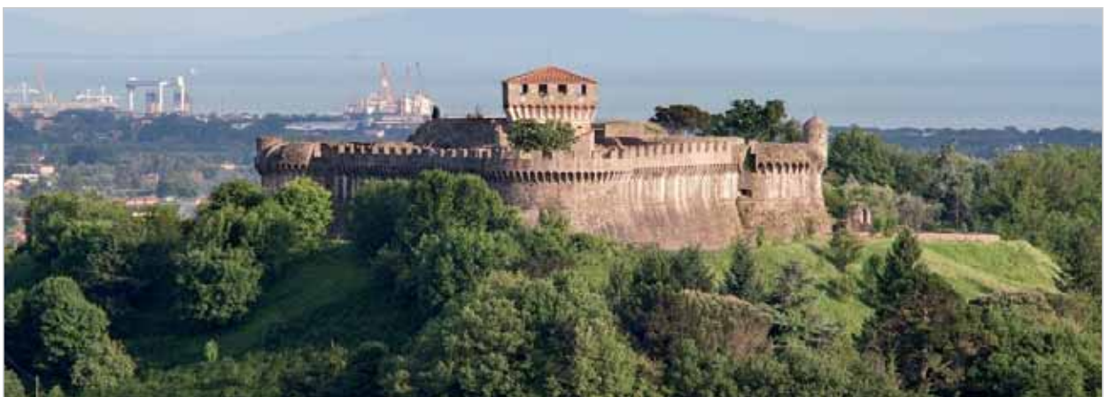
Fig. 5- Il Forte di Sarzanello visto da Nord, all'interno del contesto paesaggistico della bassa val di Magra (da www.sarzanello.com )
