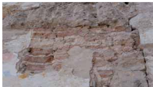
Fig. 15- Interfaccia di demolizione di una parete perpendicolare alla facciata, che fa parte del tamponamento dell'arco
