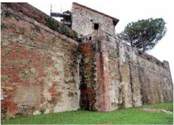
Fig. 5- Il mastio con i resti dell’intonaco originale
