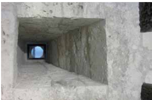
Fig. 15- Dettaglio dell'apertura per artiglieria (settore 2 Fig. 2)
