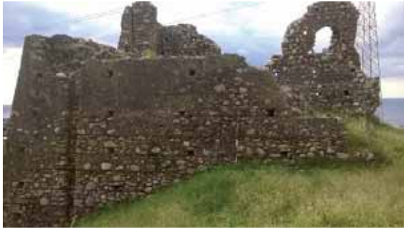
Fig. 6- Veduta lato nord (foto autografa, 2015)
