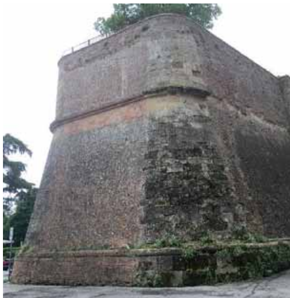
Fig. 3- Fortezza medicea (Siena), settore del paramento murario del Bastione di San Domenico, realizzato in laterizio e conci di arenaria pliocenica
