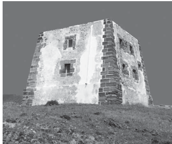
Fig. 8- La torre dello Spalmadore
