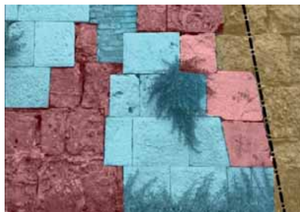
Fig. 4- Dettaglio del Bastione della Concezione: disposizione della scarpa in prossimità della cortina di San Guglielmo. In rosso sono indicati i conci riconducibili alla cortina del XVI sec., in giallo il muro realizzato nel XIX sec. a seguito delle demolizioni, in ciano i successivi restauri
