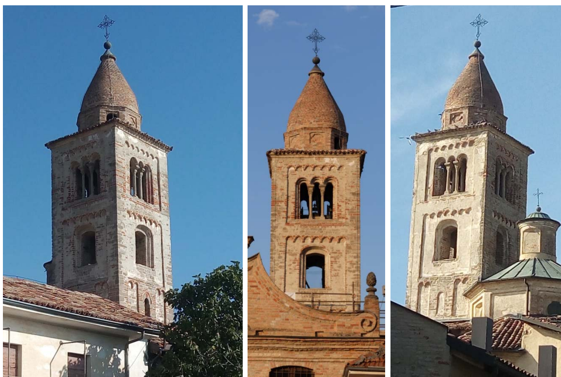
Tre immagini del campanile di San Martino a La morra: al livello più basso si identifica la presenza della monofora che risulta tamponata verso est, ma ancora aperta sul lato sud.
