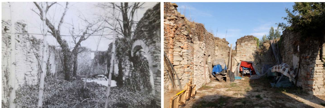
Santa Maria del Podio, Novello. Le differenze tra la condizione alla fine degli anni Ottanta e attuale. Fonte foto in B/N: G. ARBOCCO 1988, p. 47.
