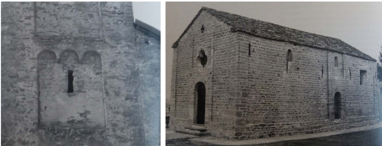
Torre campanaria di San Marziano a Roccaforte e Sant'Antonino a Perletto (in ARDITI 2004, pp. 184, 164).
