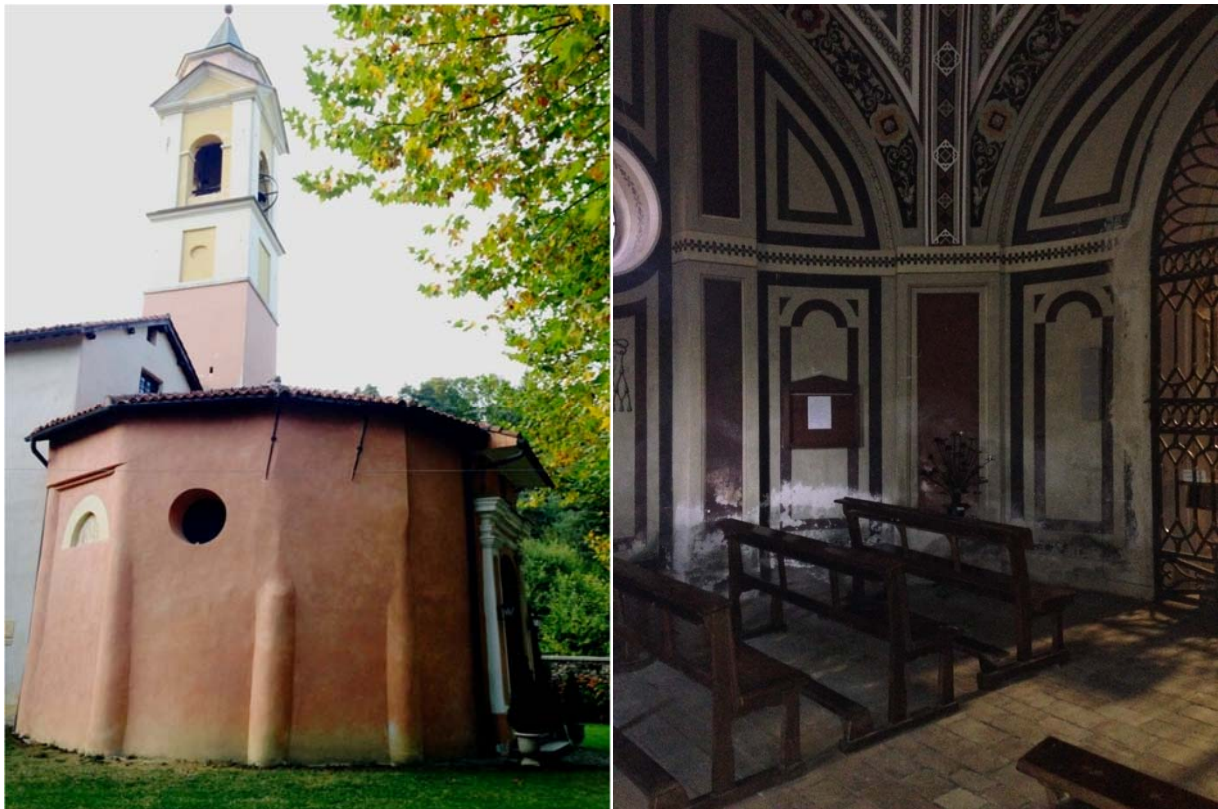
La chiesa di Mallare: l'ingresso risulta corrispondere con l'originaria struttura medievale.
